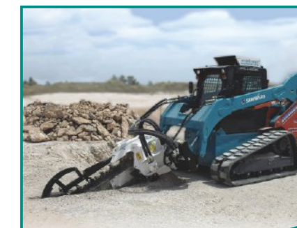
Копание траншеи в США
